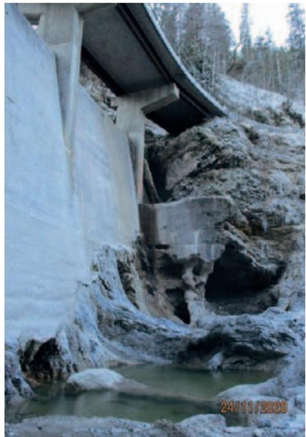
Infolge der hohen Wasserdurchlässigkeit des frisch abgelagerten Geschiebes im Unterwasser wurde das Gewässerbett der Dürrach auf einer Länge von etwa 100 m eingetieft, um die erforderliche Wasserhaltung der tiefliegenden Kolke einigermaßen im Rahmen zu halten. Trotz alledem musste der tiefste Kolk mit Unterwasserbeton ausbetoniert werden, der Wasserandrang war für eine herkömmliche Betonage zu groß. Diese Arbeiten wurden Ende des Jahres 2022 abgeschlossen.
